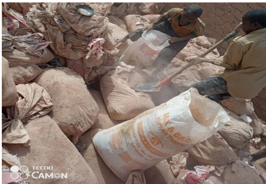
Photo 1: Sacs des pierres à concasser
